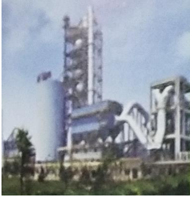
陕西省尧柏水泥厂（韩城市） 熟料产能 2500t/d，实际熟料产量可达 3500t/d 回转窑 \phi 4.0\text{m}\times 60\text{m} ，熟料标准煤耗 \approx 0.1\text{kg/kg}
