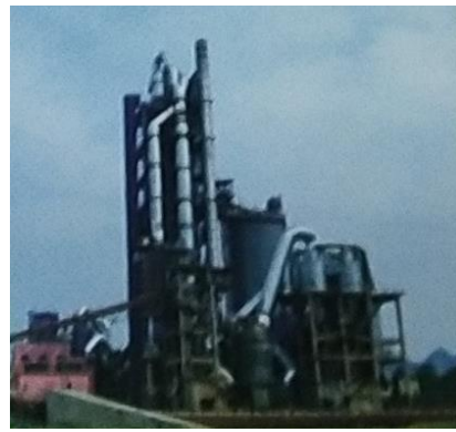
广西壮族自治区崇左水泥厂（崇左市） 熟料产能 5000t/d，实际熟料产量可达 6350t/d 回转窑 \phi 5.0\text{m}\times 60\text{m} (两档窑)，熟料标准煤耗 0.0965\text{kg/kg}
