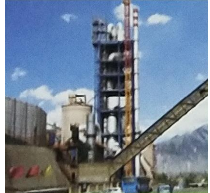
甘肃省祁连山水泥厂（青海省民和县） 熟料产能 2000t/d (技改)，可增产 20% 熟料标准煤耗降低 0.034\text{kg/kg}
